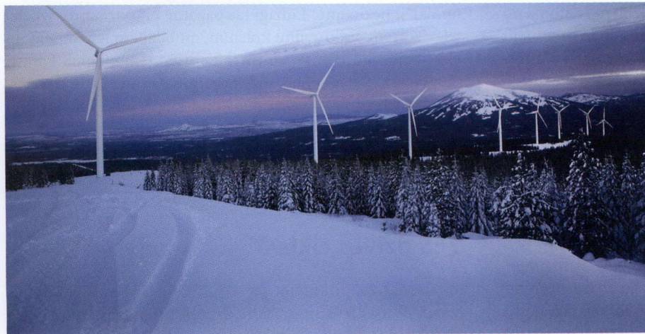
Mūsu platuma grādos, lai izvairītos no apledošanas radītās ietekmes, vēja turbīnās tiek izmantotas pretapledošanas un atledošanas tehnoloģijas
