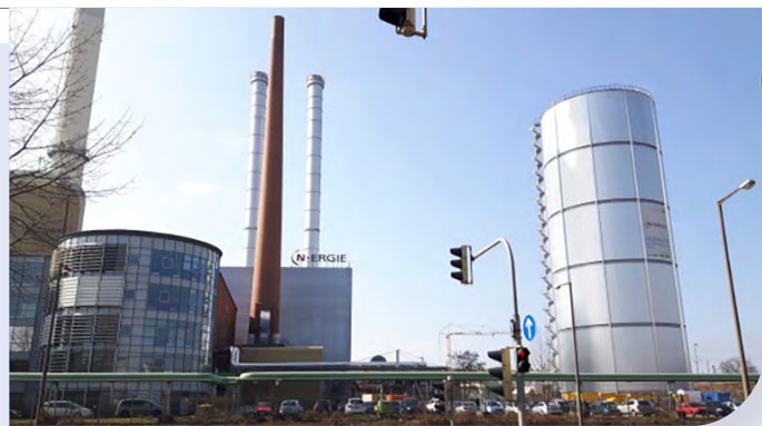
N-ERGIE uzņēmuma Sandreuth elektrostacija Nirnbergā (Vācija), kurā 2014. gadā tika uzbūvēts lieljaudas siltuma akumulators ar tilpumu 33 000 m 3 .
