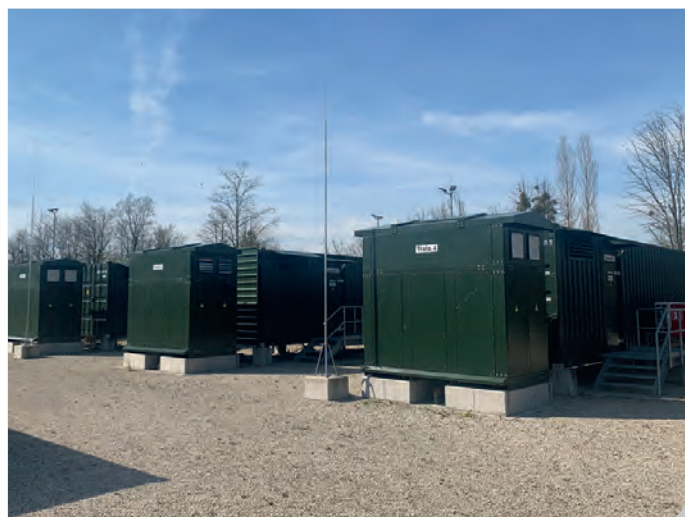
Attēls. Akumulatoru baterija (BESS)
