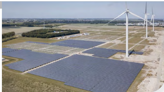
Attēlā. Vattenfall būvētā Energy Park Haringvliet Zuid hibrīda elektrostacija
