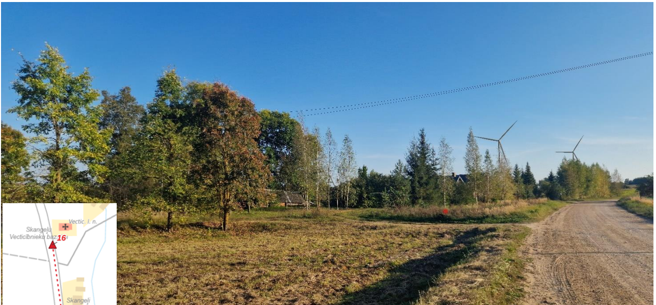
22. attēls. Skangeļu vecticībnieku lūgšanu nams – skats no vietējās nozīmes ceļa V764 (Petrovski–Skangeļi) (3D vizualizācijas punkts nr. 16, attēls 2024. gada septembris). Priekšplānā viensēta Skangeļi un elektrolīnijas gaisvadi. Tiešā redzamība no lūgšanu nama apauguma un priekšā esošās viensētas dēļ nav paredzama, taču vēja turbīnas būs ļoti redzamas no ceļa.
