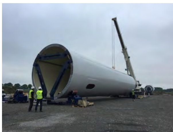
1.11. attēls. Vairāku segmentu VES masta posms (Vestas LDST; http://terralwind.com )
