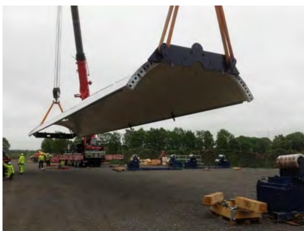
1.11. attēls. Vairāku segmentu VES masta posms (Vestas LDST; http://terralwind.com )
