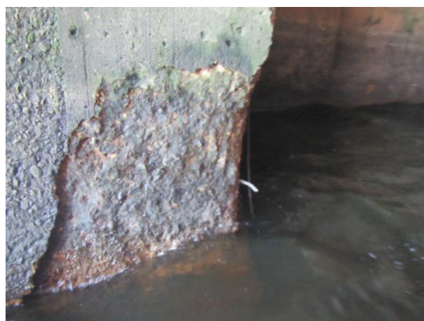
3. att. Virsmas izdrupums balsta stūrī
