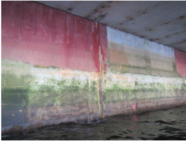
8. att. Virsmas plaisājumi un izsāļojumi spirālkameru sienai.
