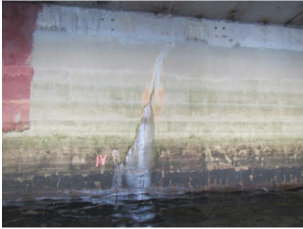
6. att. Filtrējoša plaisa spirālkameru sienā.
