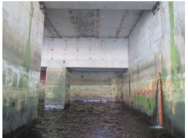
11. att. Virsmas erozija un plaisājumi, nepilnīgs ūdens novadīšanas sistēmas izvada risinājums.
